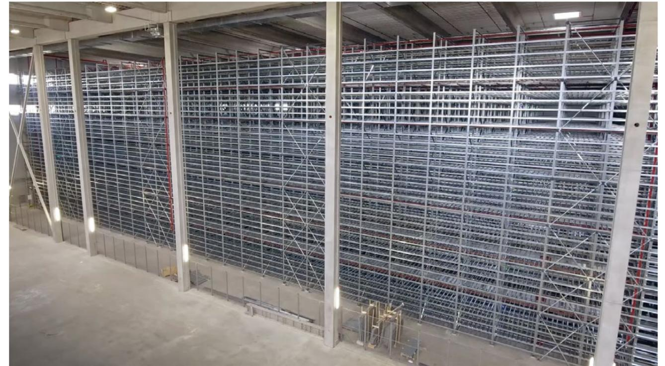
Das automatische Lagersystem bietet unterbrechungsfreie Verfügbarkeit für bis zu 130.000 Artikel wie Bauteile, Stromversorgungen, Lüfter oder Halbleiter.
